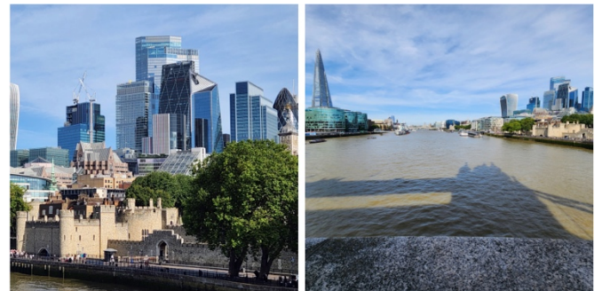
写真2：ビュー・コリドーの死角に建設された高層ビル
