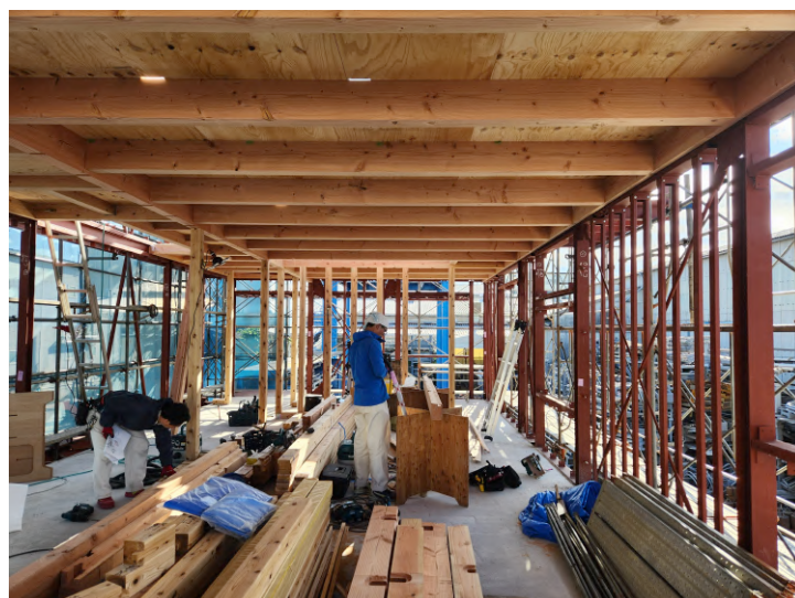
建て方時の状況-2
