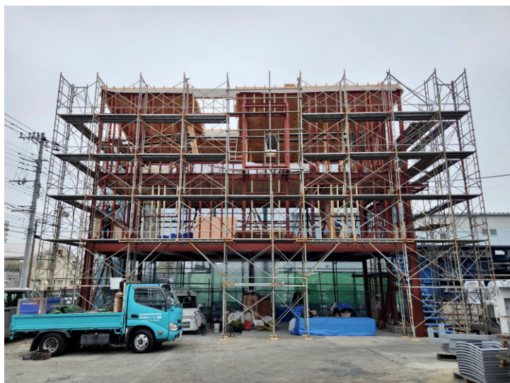
建て方時の状況-1
