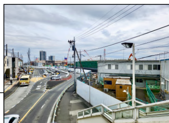
橋本駅前の景観-2： リニアモーターカー駅の工事現場
